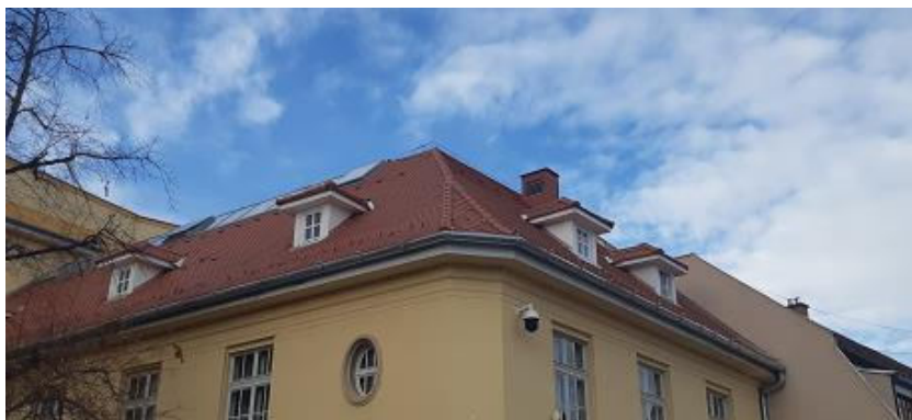
EGRI LENKEY JÁNOS ÁLTALÁNOS ISKOLA TETŐSZERKEZETE
